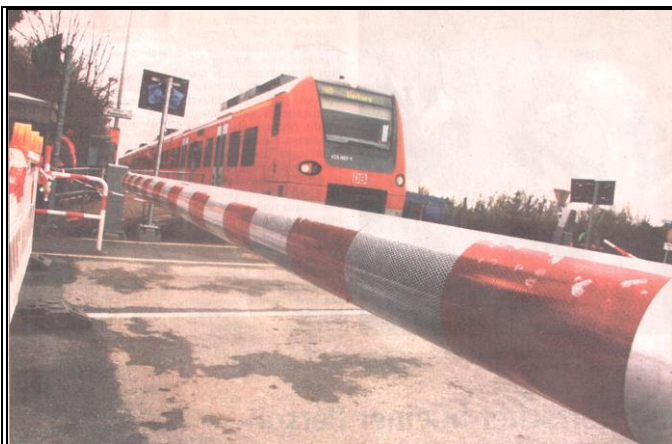
Nach 15 Monaten fällt in Dedinghausen endlich wieder die Schranke. Nachdem in den vergangenen Wochen eine neue Signalanlage am Bahnübergang in Dedinghausen installiert wurde, trennen nun auch die bekannten rot-weiße Schranken den heiß diskutierten Überweg zwischen Dedinghausen und Esbeck. Für den Straßenverkehr passierbar wird die Verbindung zwischen den Ortschaften jedoch erst Anfang Februar sein. Seit November 2006 war der Bahnübergang Am Kusel nicht mehr durch Schranken, sondern durch Streckenposten und „Flatterband“ und zuletzt durch Vollsperrung gesichert worden. ■ Foto: Krumat
