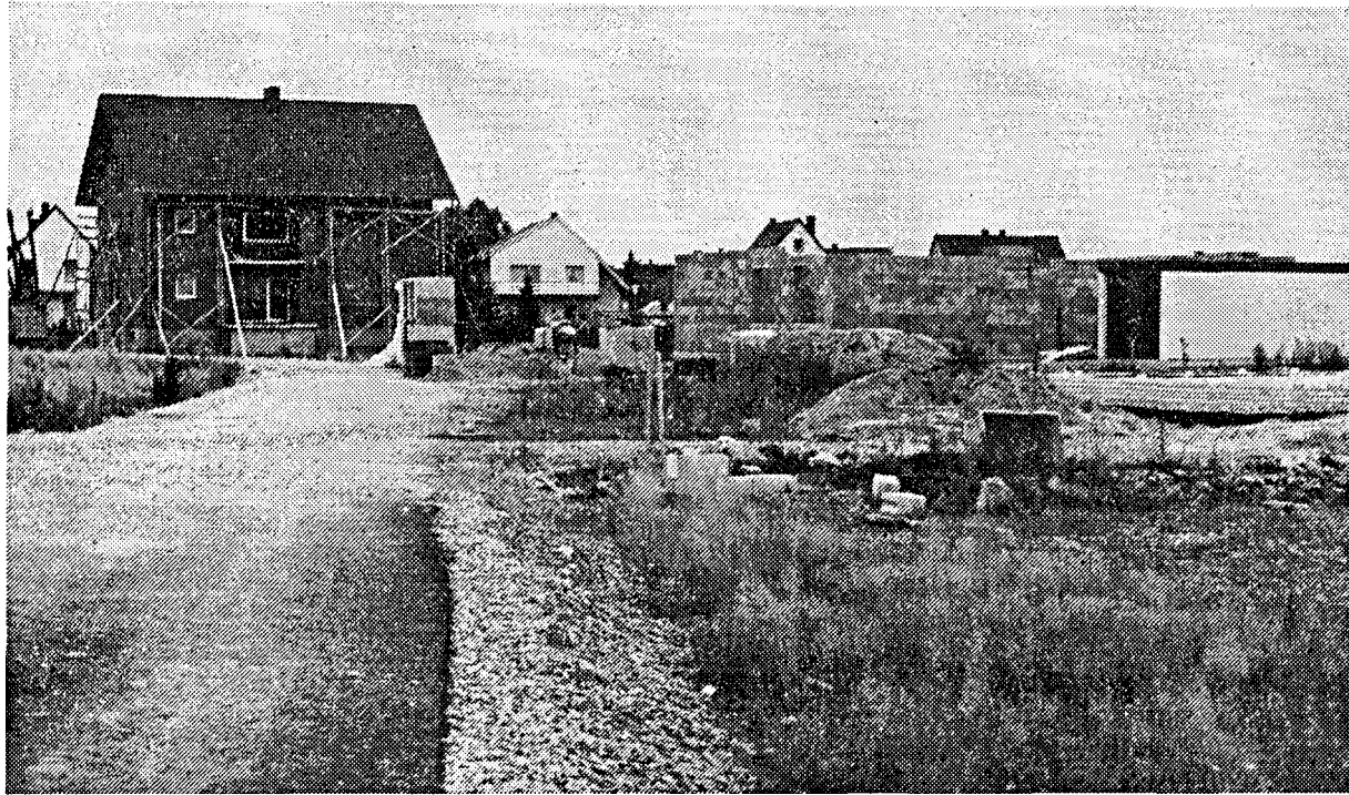
Wie Pilze schließen im Baugebiet am Sportplatz die Neubauten aus dem Boden. Für dieses Projekt sind die Kanalisationsarbeiten im Tiefbauprogramm '83 enthalten.
